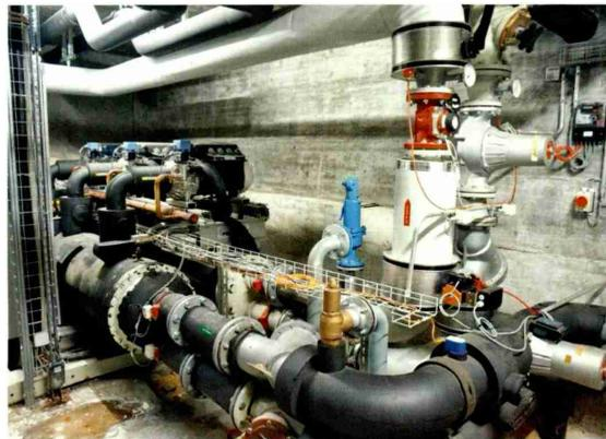
Mit einer Wärmepumpe wird aus dem Abwasserreservoir noch die letzte Wärme herausgeholt. Auf der linken Seite kann man die Verdichter erkennen.
