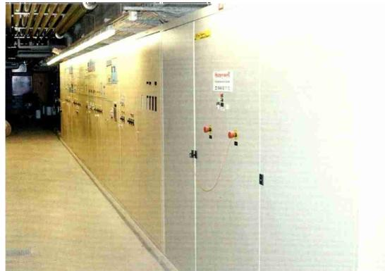
*Der hintere sehr lange Steuerschrank ist ausser Betrieb und wurde durch den vorderen Teil ersetzt*
